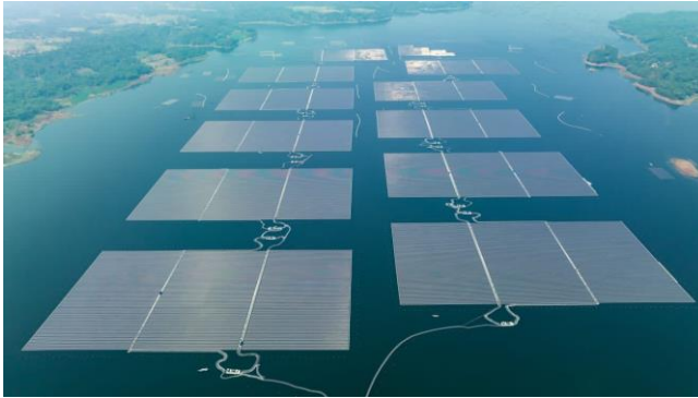
Gambar 6. Pembangkit Listrik Tenaga Surya (PLTS) Terapung Cirata, Jawa Barat dengan Kapasitas 145 MWac/192 MWp [7]
