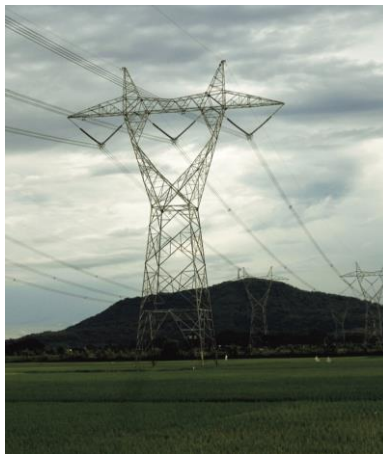
Gambar 7. SUTET Ungaran - Ngimbang/Krian SUTET 500 kV [8]
