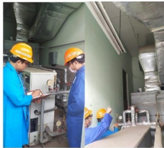
Gambar 2.1 Pengamatan sistem pengkondisian udara sentral
