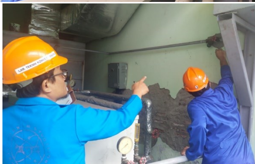
Melakukan Pengukuran Temperatur dan Tekanan
